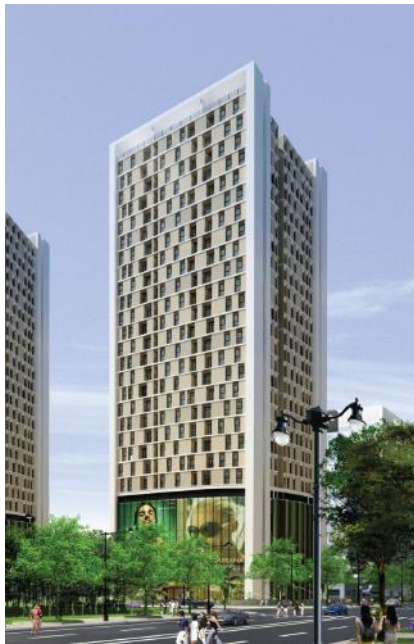
Toà nhà N02 - T3 Khu Ngoại Giao Đoàn
