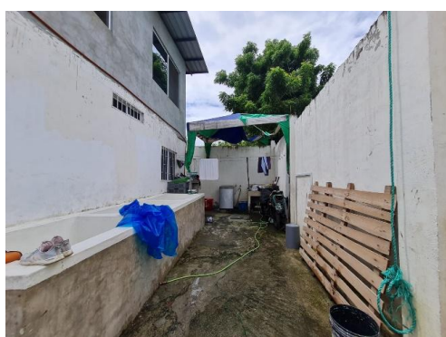
Vista de patio lateral
