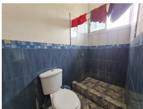
Vista de baño de dormitorio 4 P.A.
