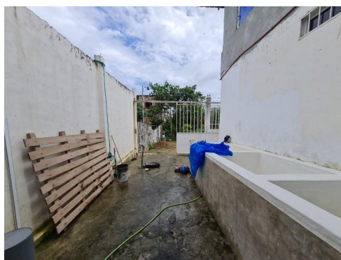
Vista de patio lateral
