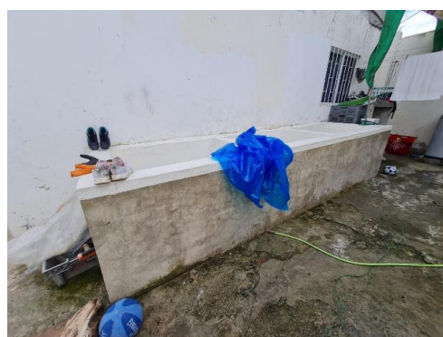
Vista de reservorio en patio lateral
