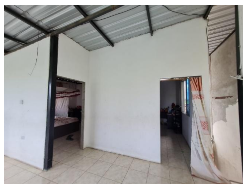
Vista de acceso a dormitorios P.A.
