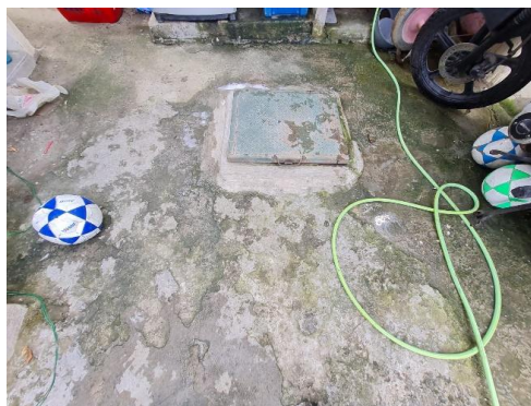
Vista de cisterna
