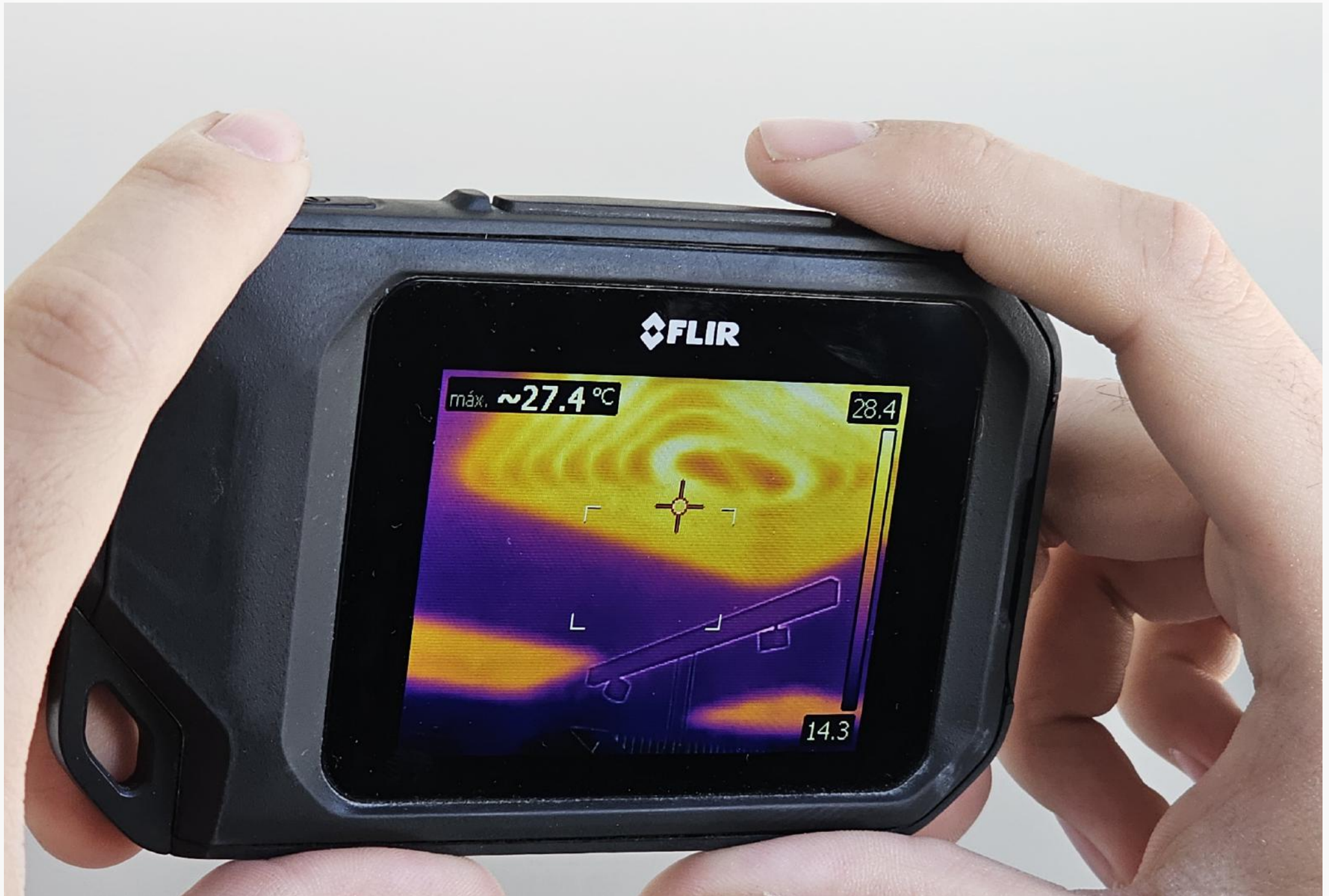
visualización de paneles radiantes a través de cámara termográfica
