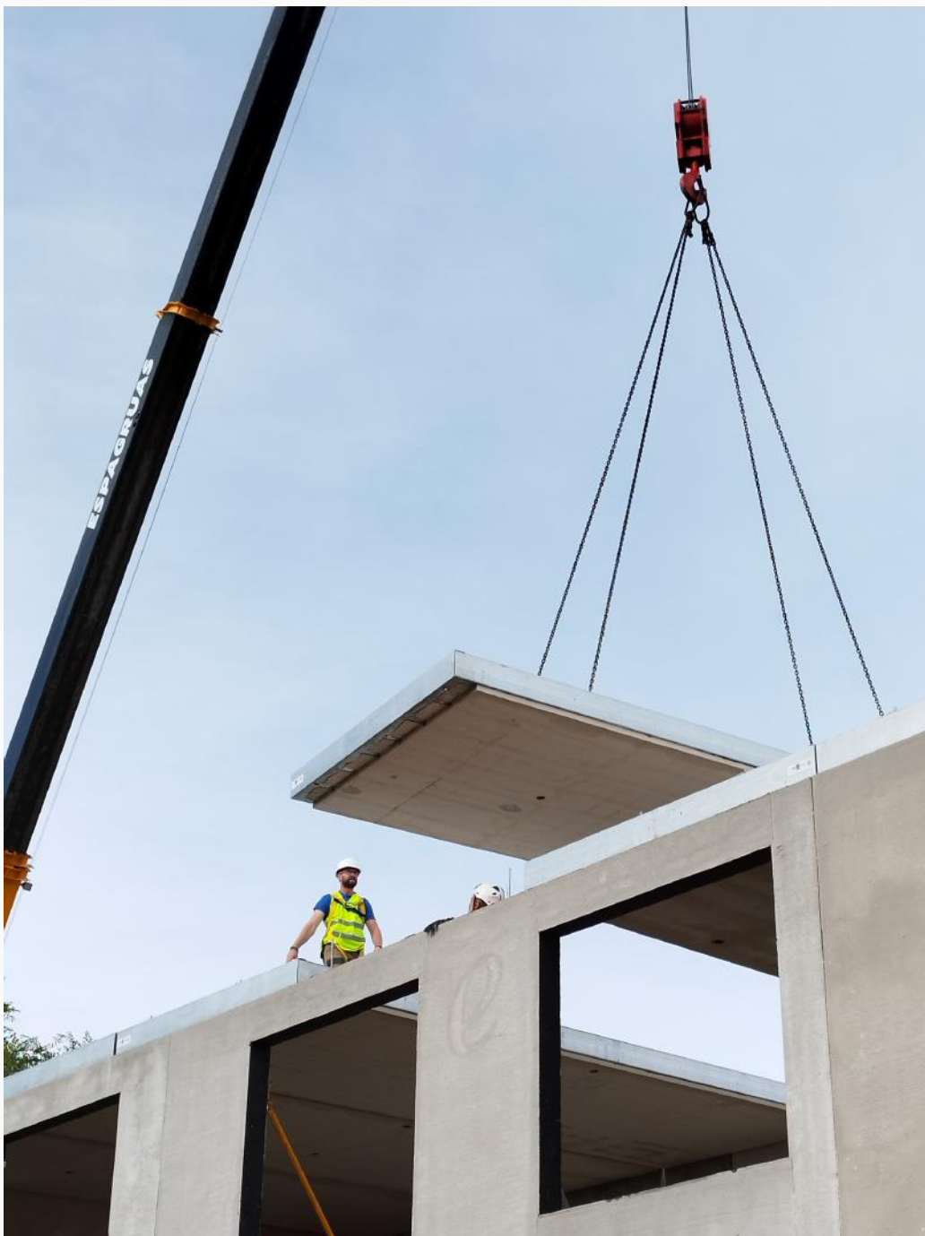
visita técnica a montaje de paneles industrializados
