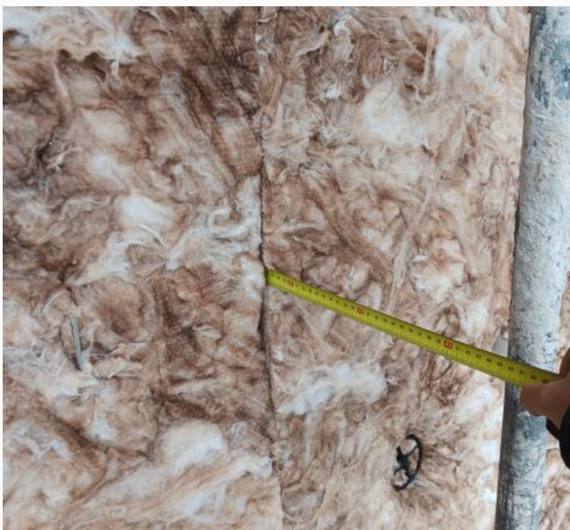
fachada ventilada yz hub lana 16mm
