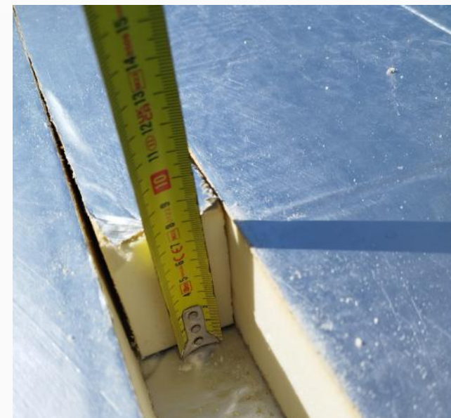
cubierta YZ HUB, PIR 160mm
