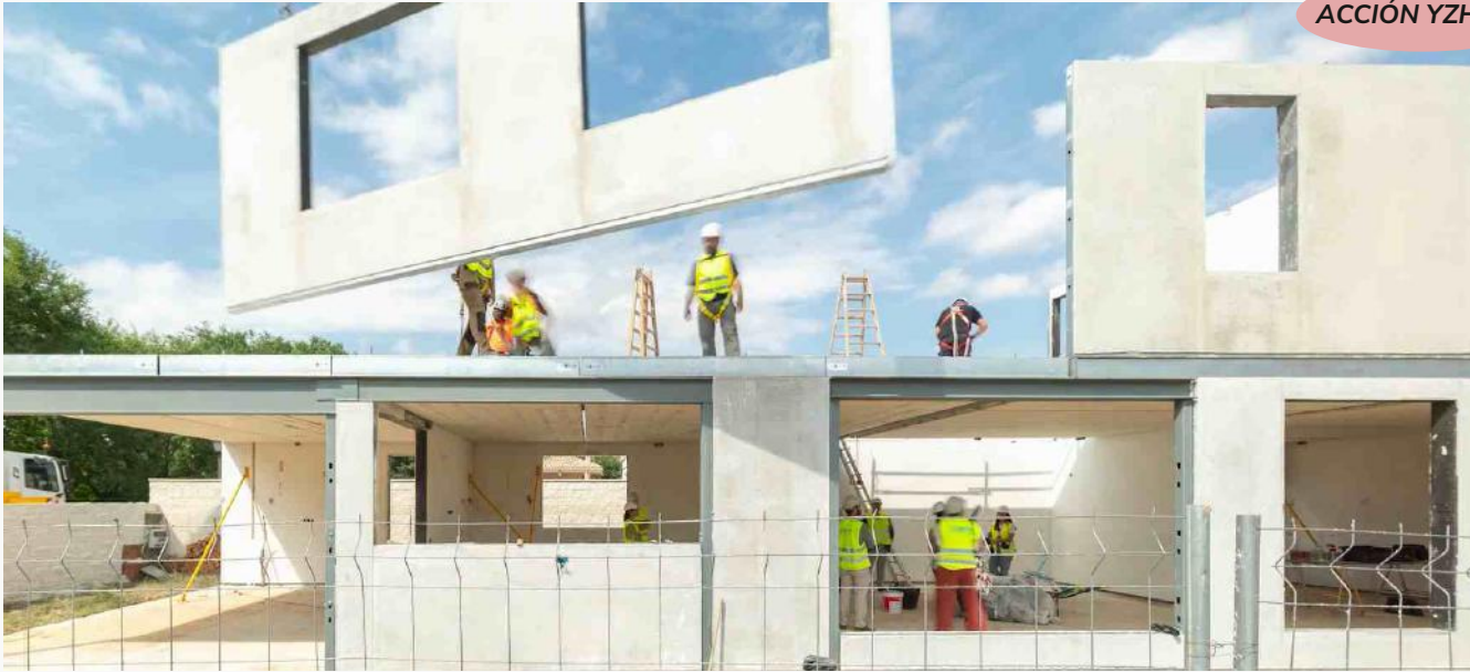
visita técnica a montaje de paneles industrializados
