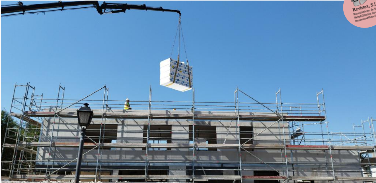
subida de paneles a cubierta no transitable
