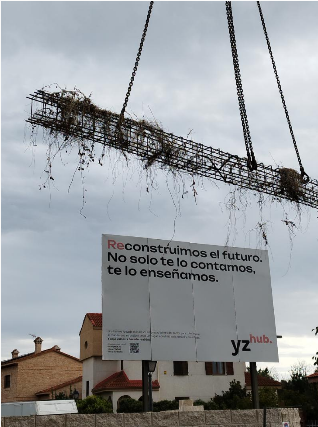
cartel de obra desde el exterior
