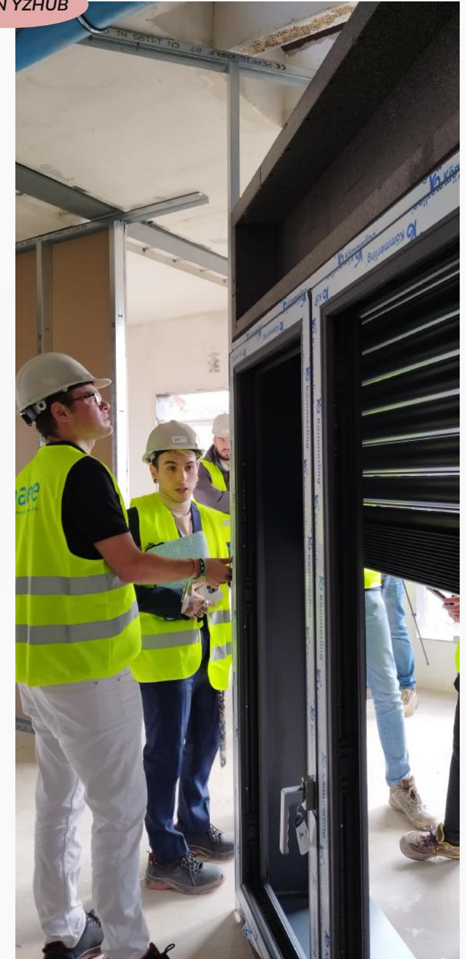
visita de obra Hueco industrializado
