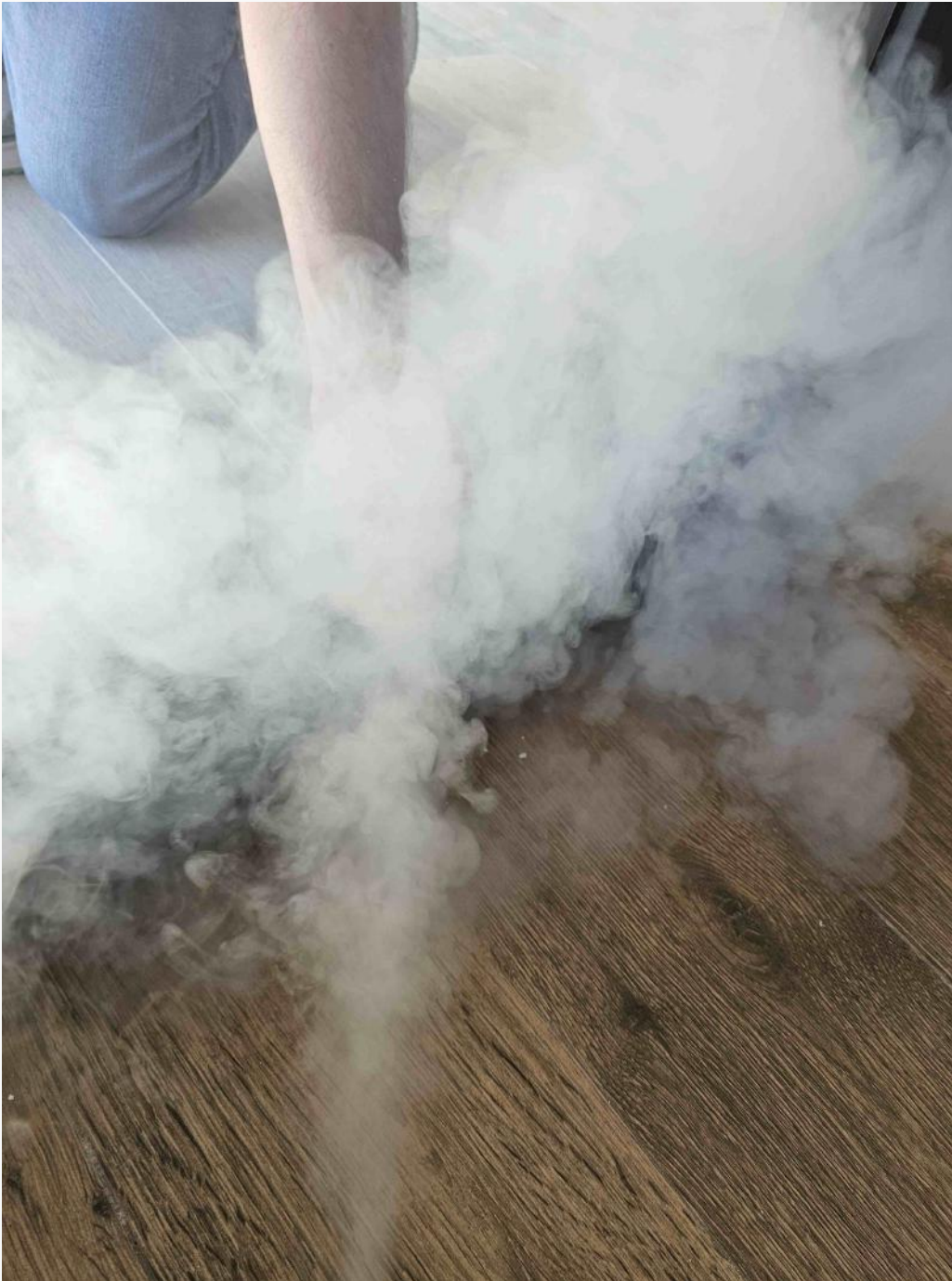
prueba de estanqueidad de ventanas con máquina de humo
