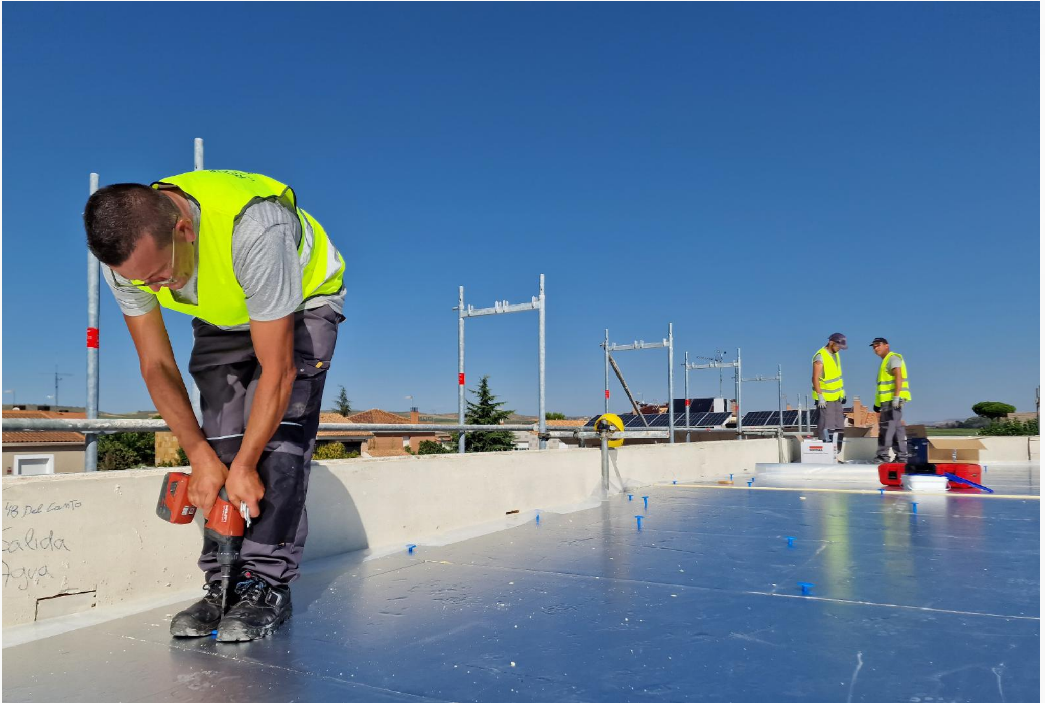
instalación de paneles PIR en cubierta no transitable
