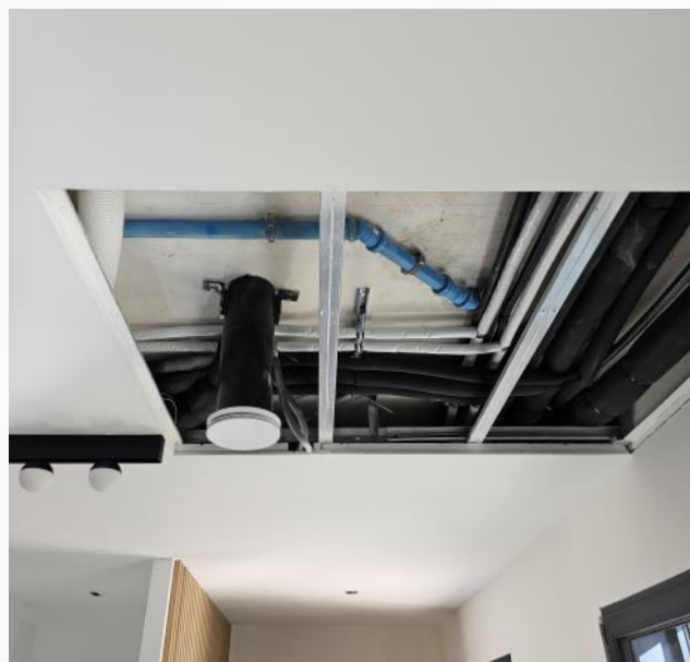
apertura en techo para mostrar ventilación en YZ HUB
