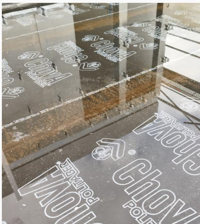
prueba de estanqueidad en cubierta Poltaber
