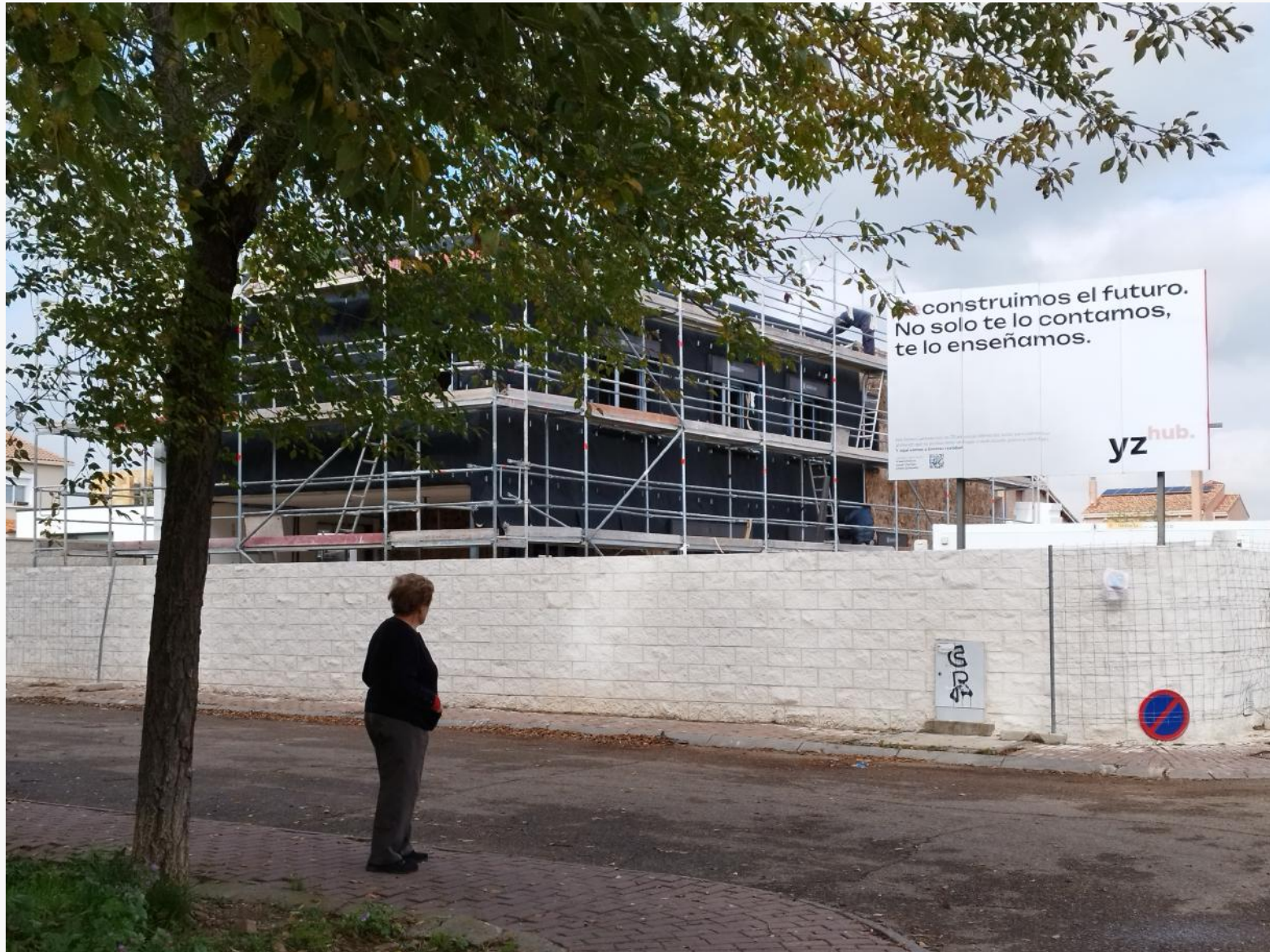
vecina y cartel de obra
