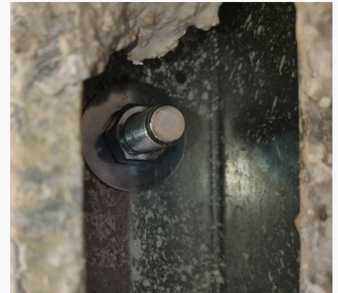
anclaje de panel industrializado
