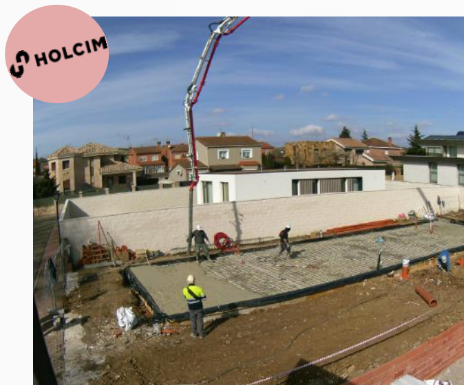
hormigón para cimentación
