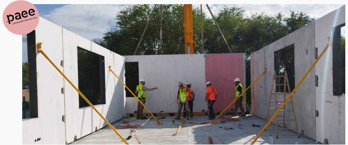
colocación de paneles industrializados
