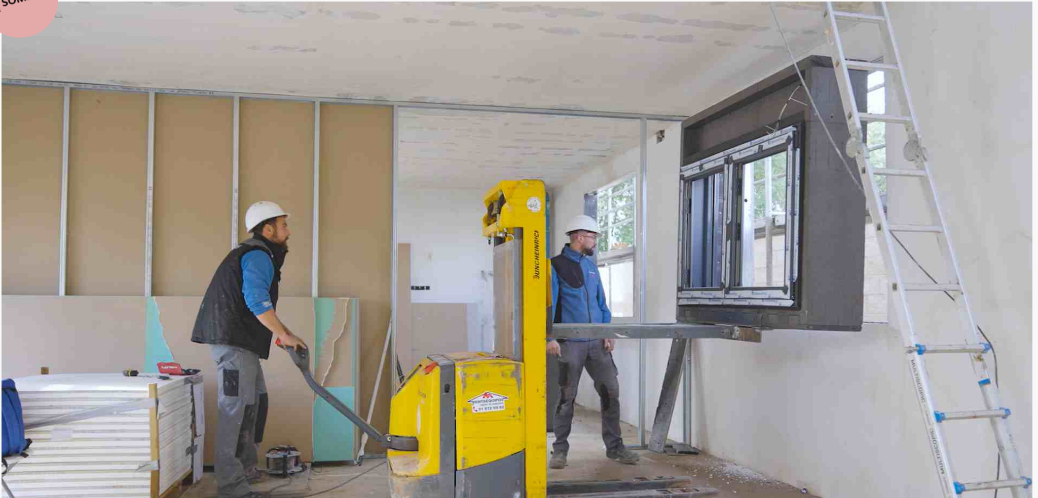
instalación con carretilla elevadora de hueco industrializado
