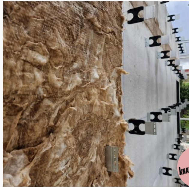
ménsulas Hilti y aislamiento de Knauf Insulation
