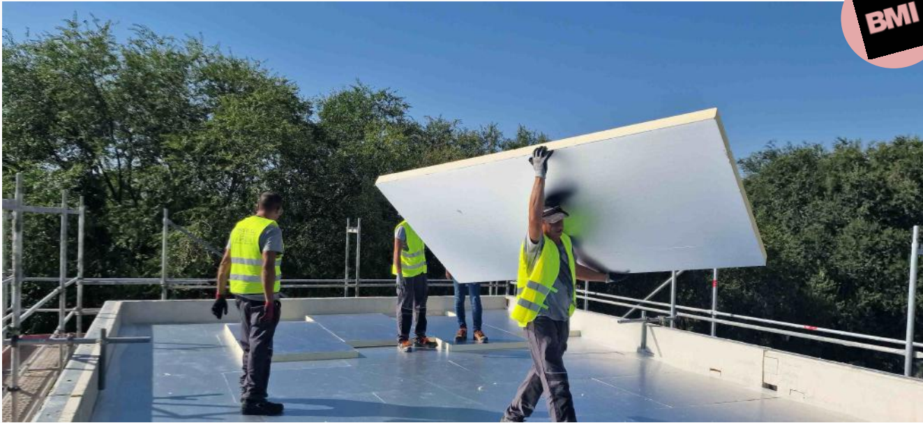
instalación de placas PIR en cubierta no transitable
