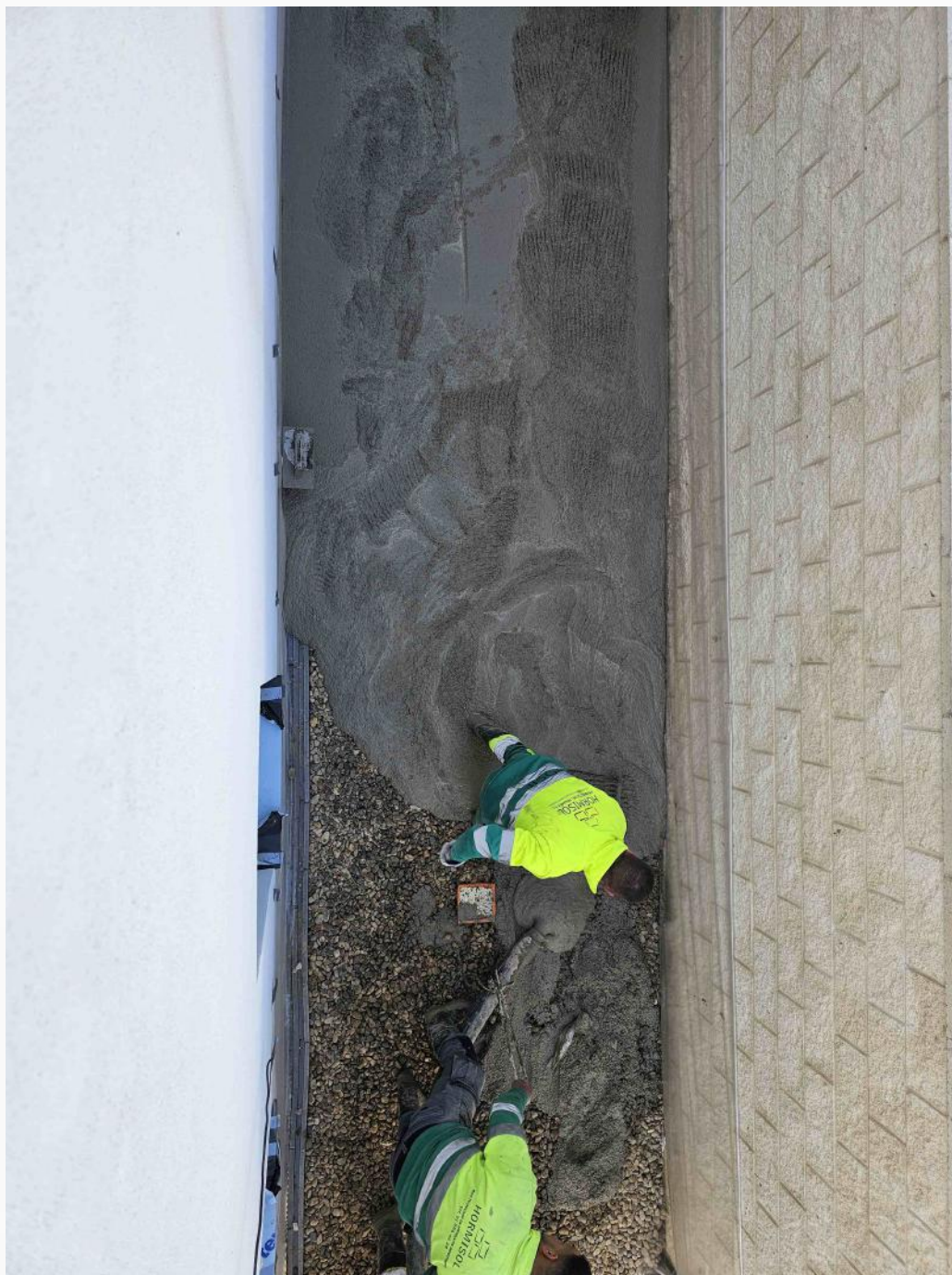
ejecución de pavimento de hormigón que se rayará manualmente
