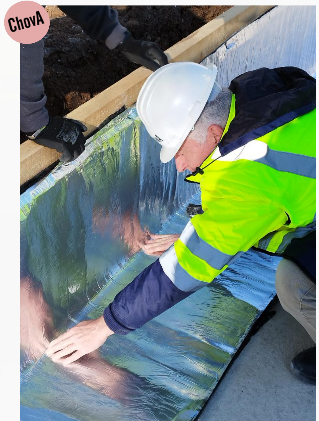
colocación de láminas de Chova
