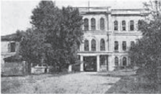
Resim 160 ■ Askeri Tıbbiye'nin Demirkapı'daki son idare binası (43).
