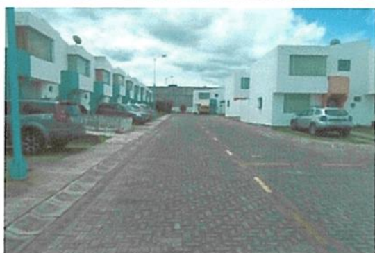
CALLE INTERNA DEL CONJUNTO
