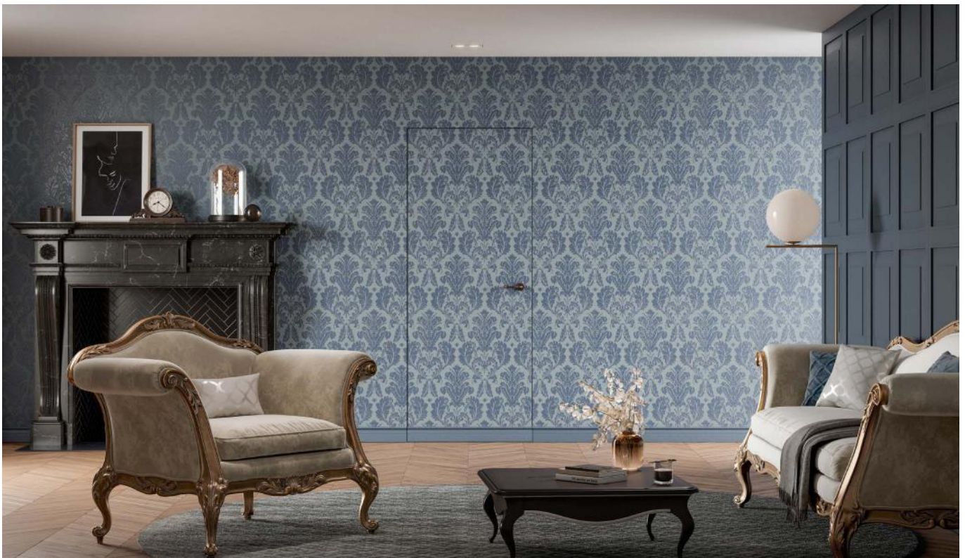
Tapetentür in ihrer ursprünglichen Verwendung - lediglich die Drückergarnitur und eine feine umlaufende Fuge lässt eine Tür erkennen.
