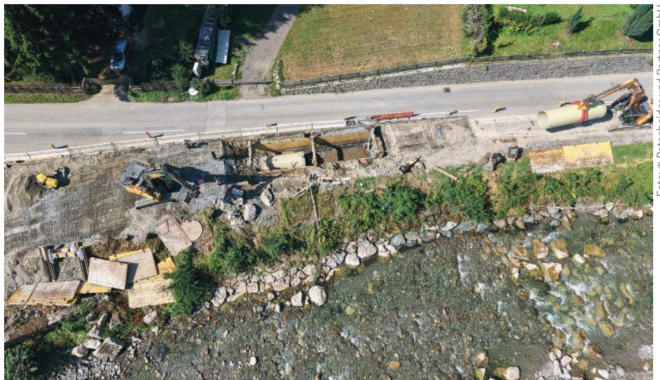
Verlegung der Druckrohrleitung
