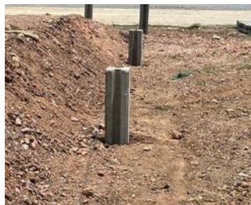
เสาเข็มตัวไอ แบบเดี่ยว
