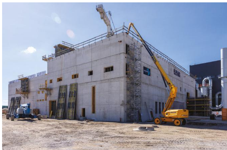
Die Arbeiten sind in vollem Gange, die Inbetriebnahme des europaweit einzigartigen Projekts ist für Mitte 2027 geplant.
