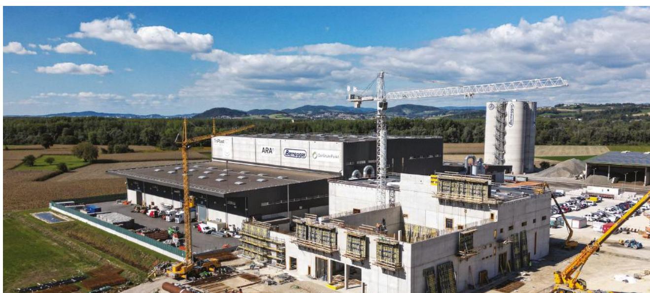
Sort4cycle nimmt Gestalt an: Rund fünf Monate nach dem Spatenstich steht der Rohbau des neuen Recyclingwerks im Ennshafen. Die Anlage entsteht direkt neben der bestehenden Kunststoffsortieranlage TriPlast.
