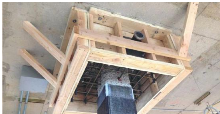
Fig. 2. Fotografía de avance de una columna de concreto dentro de un proyecto de rehabilitación. Se ha añadido un envoltorio de FRP a la columna, y se han instalado el refuerzo y el encofrado para un capitel. La rehabilitación se completará instalando y apuntalando el encofrado inferior, seguido del bombeo de concreto a través del tubo visible en el lado cercano del encofrado (fotografía cortesía de Pivot Engineers, PLLC)
