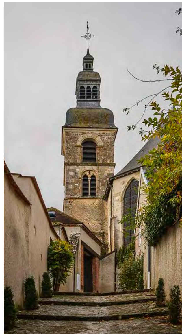
Autour du monument, la préparation du chantier va débiter le 15 septembre. © DR
