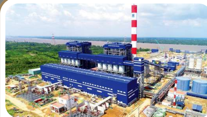
NHÀ MÁY NHIỆT ĐIỆN NHƠN TRẠCH 3 VÀ 4 TP.HCM
