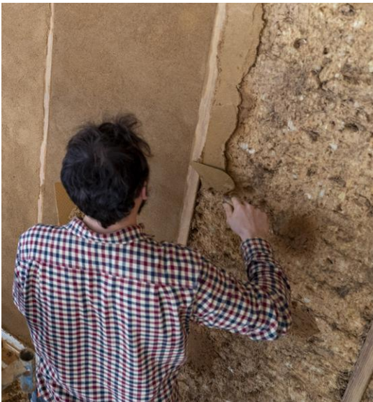
↑ Rénovation d'un bâtiment public en terre crue, à Saint-Sulpice-la-Forêt.
