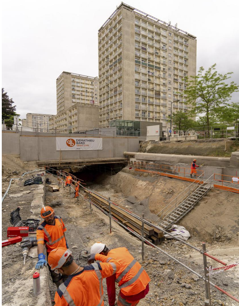
↑ Les travaux à la station J.-F.-Kennedy visent à réduire l'attente sur la ligne a.
