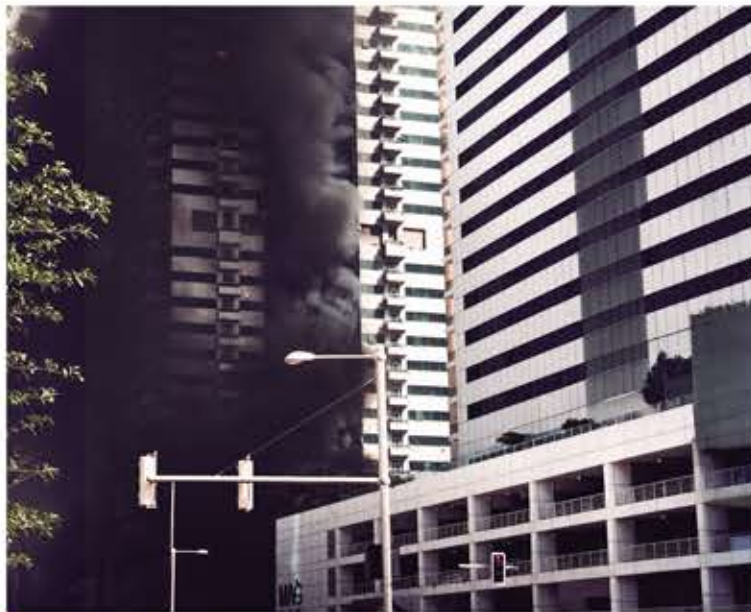
■ Manutenção contínua e preventiva para evitar incêndios
