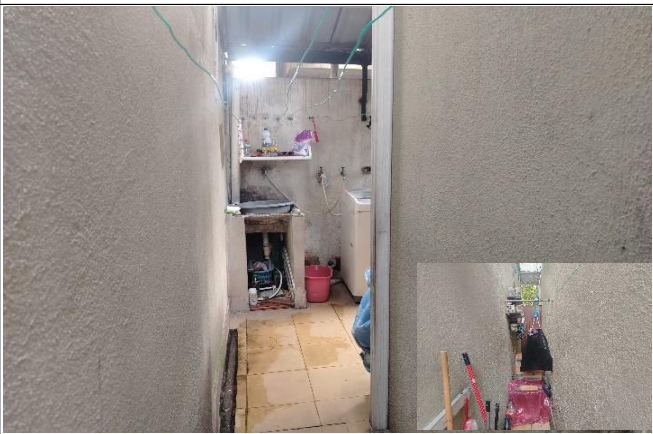
CORREDOR - RETIRO LATERAL - EXTERIOR
