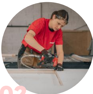
02 Fabrication et pose des cloisons
