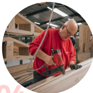
04 Préparation et assemblage de la charpente
