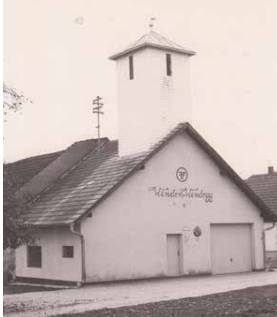
Der neu mit Eternit verkleidete Schlauchturm
