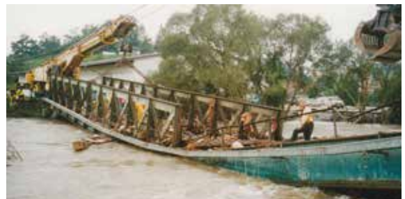
Eisenbahnbrücke in Schwertberg
