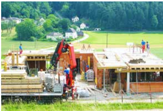
Mitte Juni ist die erste Decke zum Verlegen
