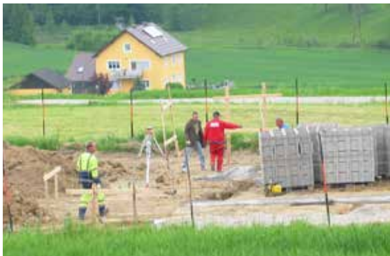
Anfang Mai startet die Baufirma Krückl aus Perg mit der Baustelle
