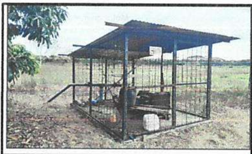
ramiento de Mallas +Cubierta y contrapiso
