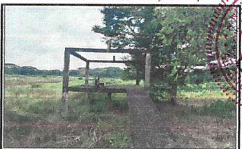
Construccion de columnas amarradas
