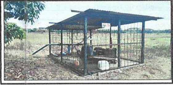
ramiento de Mallas +Cubierta y contrapiso +
