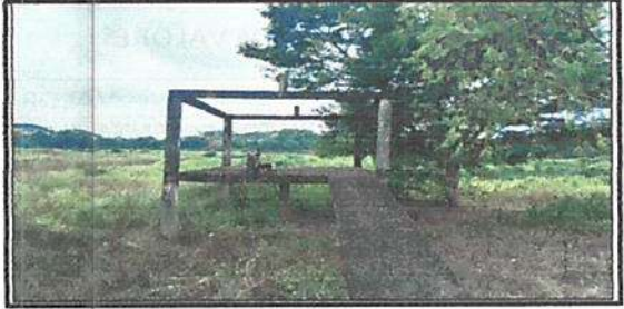
Construccion de columnas amarradas
