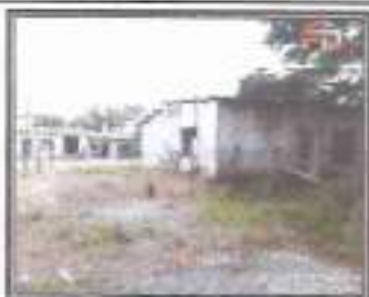
VISTA INTERIOR DEL TERRENO
