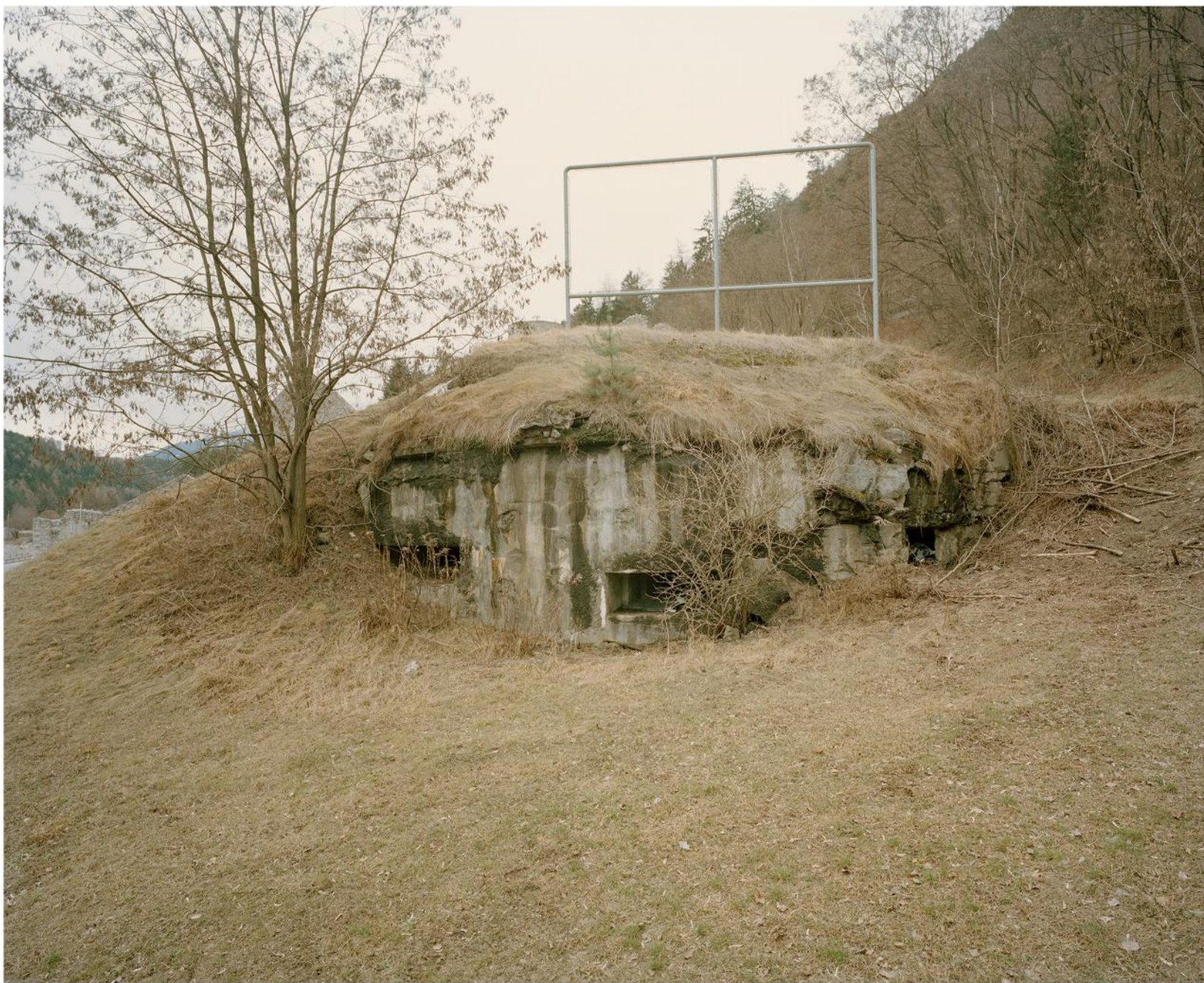
Opera 1, Chiusa di Rio
