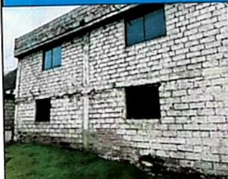
FACHA POSTERIOR EDIFICACIÓN 1
