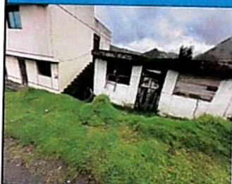
EDIFICACIÓN 2 Y PARTE DE EDIFICACIÓN 1
