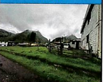
PATIO POSTERIOR EDIFICACIÓN 1
