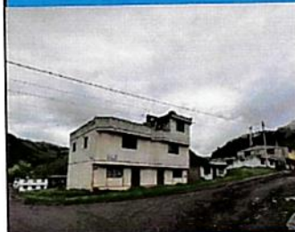
EDIFICACIÓN 1 Y EDIFICACIÓN 2
