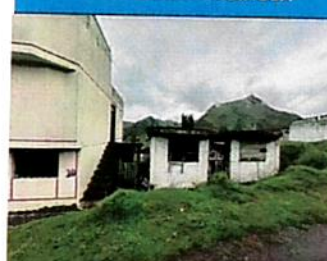
EDIFICACIÓN 2 Y PARTE DE EDIFICACIÓN 1
