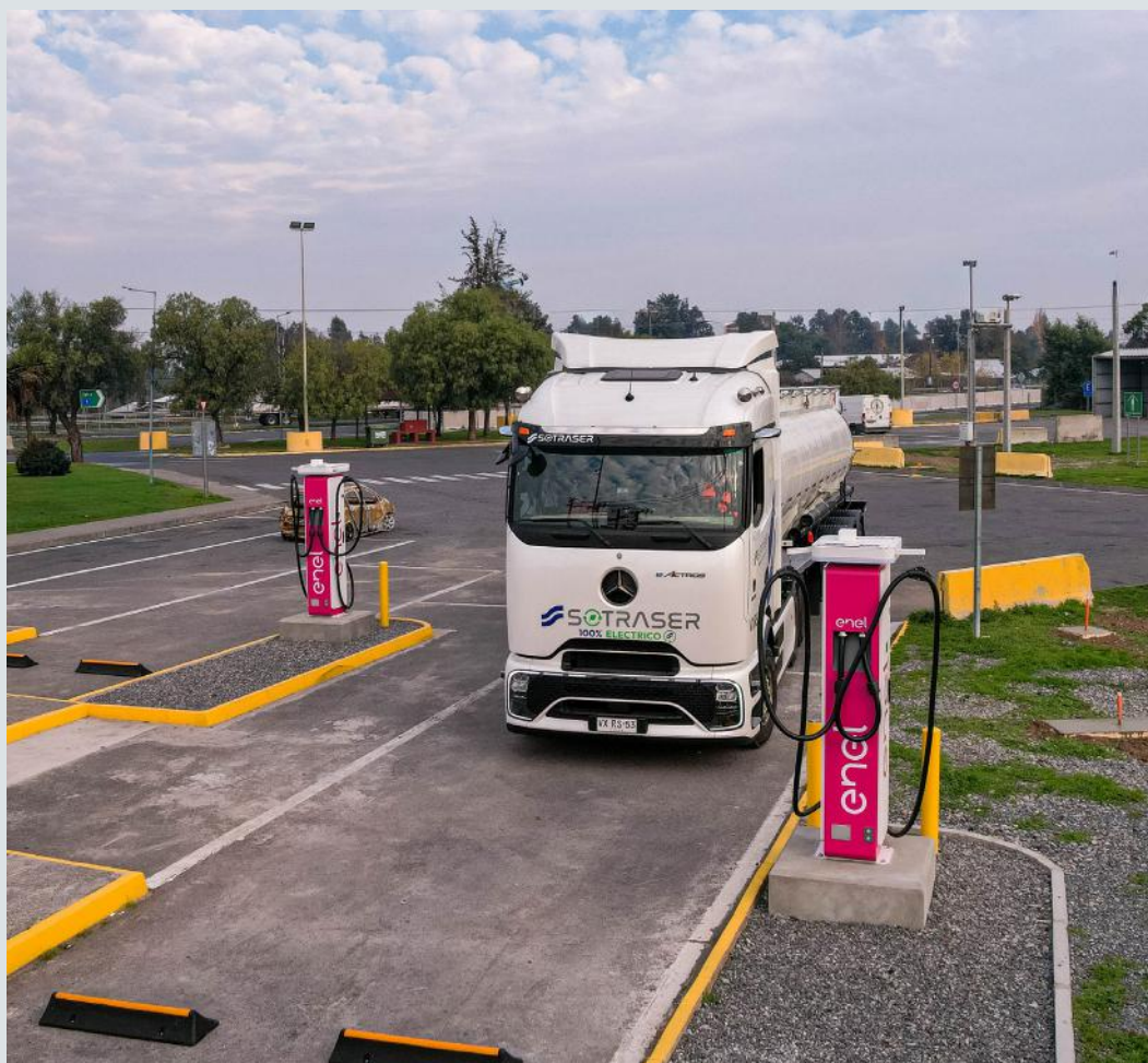
↑ Estación de servicio eléctrica, ubicada en el área de descanso Itahue en la Ruta del Maipo, región del Maule, operada por Isa Intervial.
