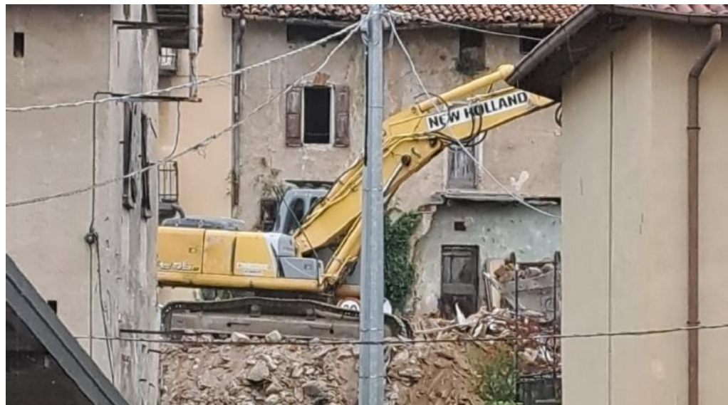
OLGIATE MOLGORA demolizione di una cascina compromessa dal terremoto di Bergamo
