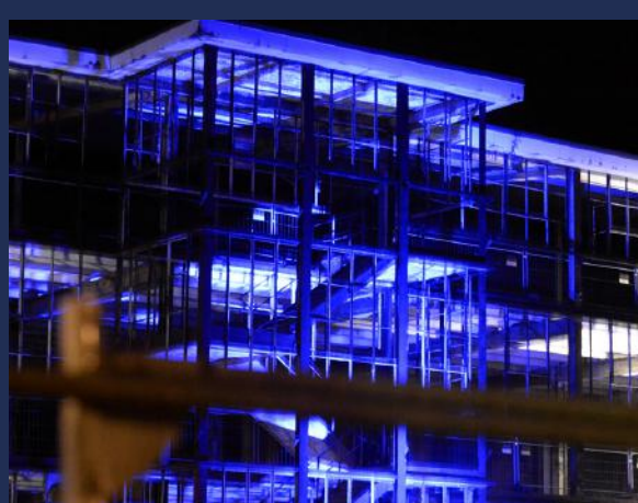
Das Stahlskelett des O1 und künftiger Wartburg-Arena
