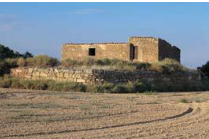
Marge de pedra a les Puelles
