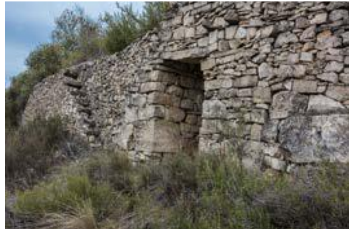
Marge de pedra a Rocafort de Vallbona
