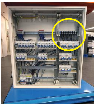
Voorbeelden toepassing rijgklemmen SRK serie
