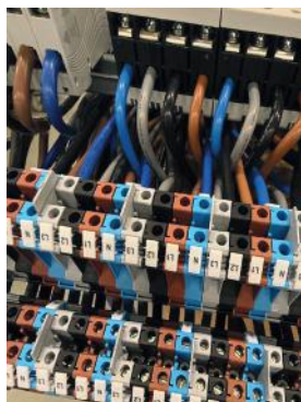
Voorbeelden toepassing rijgklemmen SRK serie
