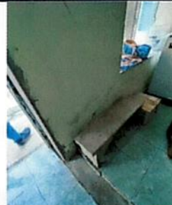
Vista interior de la edificación secundaria
