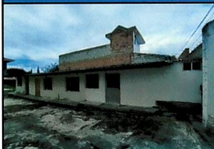
Edificación secundaria, 1P
