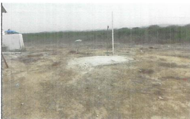
Foto #15: vista de Pozo septico
