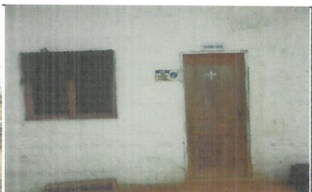
Foto #12 vista de dormitorio general
