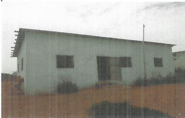
Foto #13: Vista de comedor y cocina
