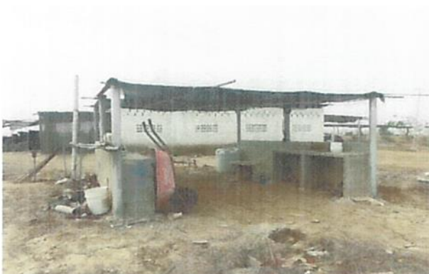
Foto #11: vista de área abierta de taller
