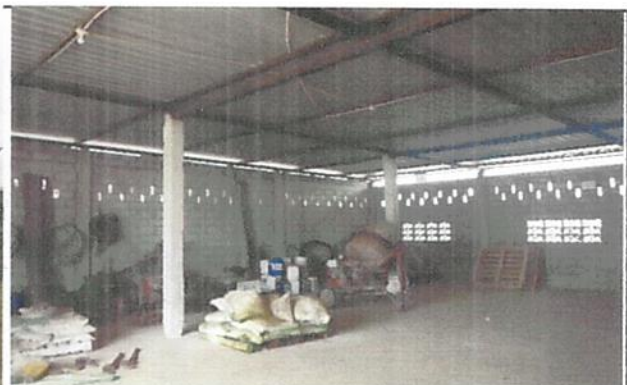
Foto #10: vista interna de la bodega
