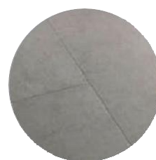
SOL ROCHE BÉTON
