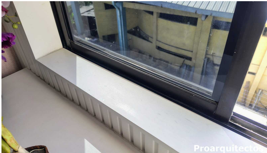
Detalle de ventanas
