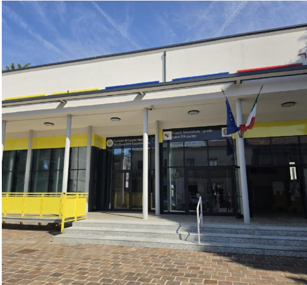
L'ingresso della Salvo D'Acquisto: il plesso scolastico è stato completamente riqualificato
