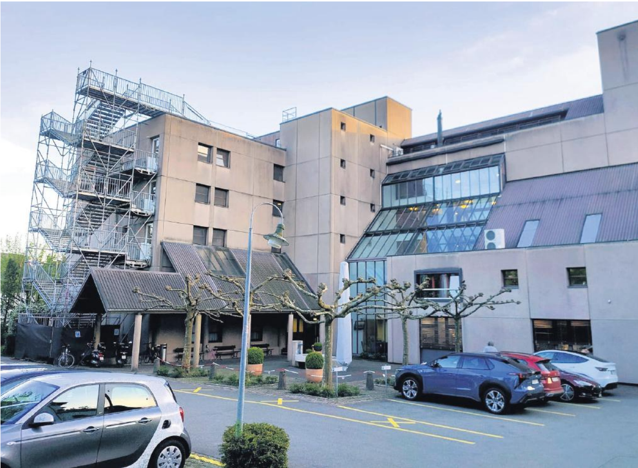
Vor dem Alterszentrum Bärenmatt fahren bald schon die Bagger auf. Trotz dreieinhalbjähriger Bauzeit soll der laufende Betrieb dabei stets gewährleistet sein.
