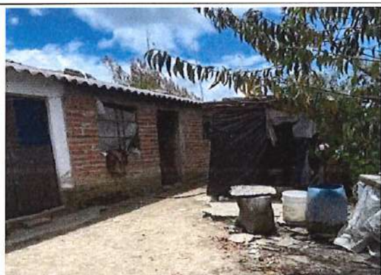
FOTOGRAFÍA N° 9 Vista general del patio (lado Este).
