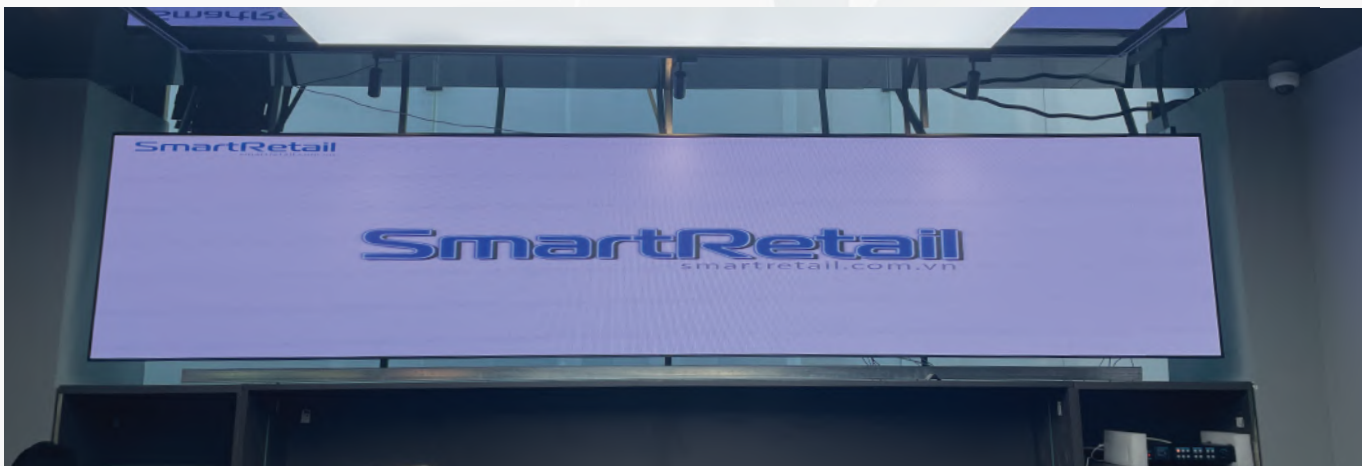
DỰ ÁN LẮP ĐẶT MÀN HÌNH GHÉP LED TẠI AUTOCARE Q7
