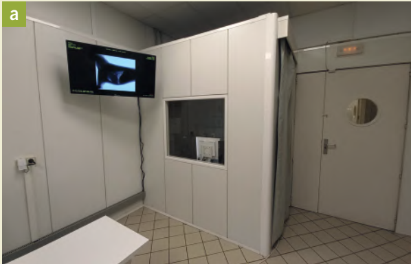
ŞEKİL 1.33. Kurşun kaplı duvarlar, tavan ve cam pencere ile çevrili kabin (a) ve operatörün X-ışınlarına maruz kalmadan cihazları çalıştırabileceği bilgisayar ekranlı kontrol paneli (b).
