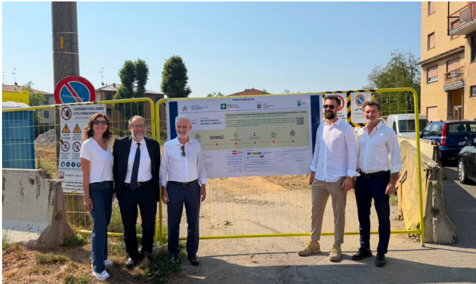
Il cantiere della nuova metrotranvia in arrivo in città
