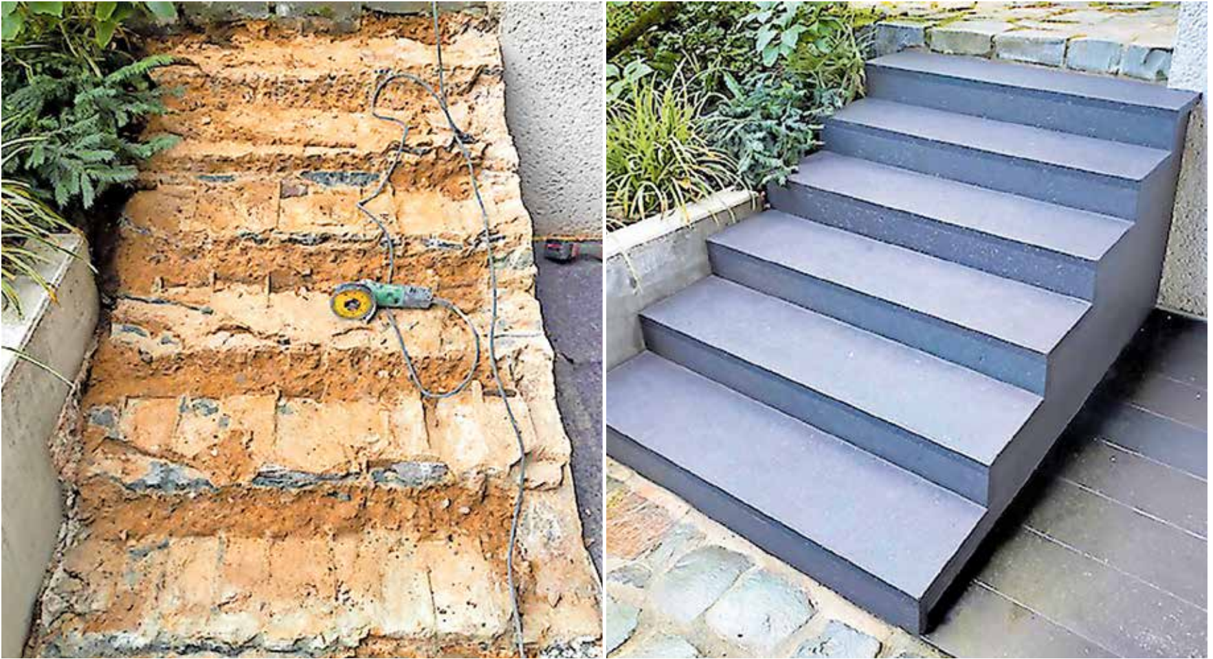
Der Treppenbau ist eine Spezialität der Firma, hier ein Beispiel für eine gelungene Sanierung vorher und nachher.
