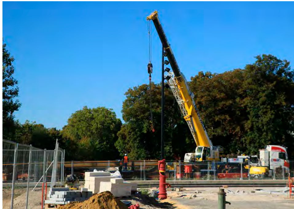
Les premiers éléments de la passerelle, visibles au pied de la grue, ont été déployés jeudi 10 septembre, le long de l'autoroute A344. © l'Hebdo du Vendredi
