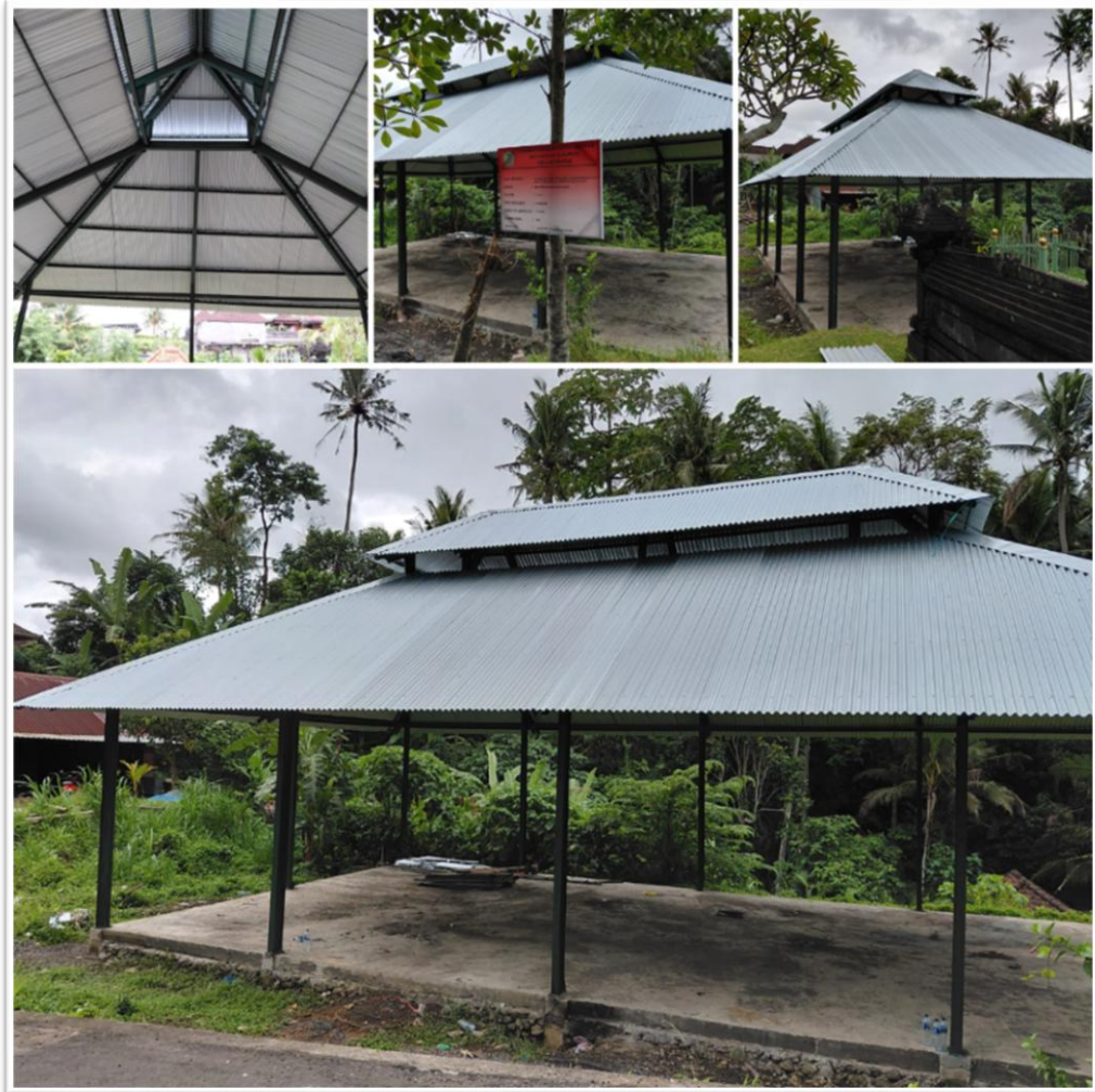
Gambar 7. 4 Pembangunan Balai Desa.
