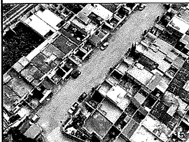
VIAS INTERNAS DE LA URBANIZACION
