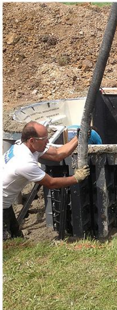
BETONIEREN
