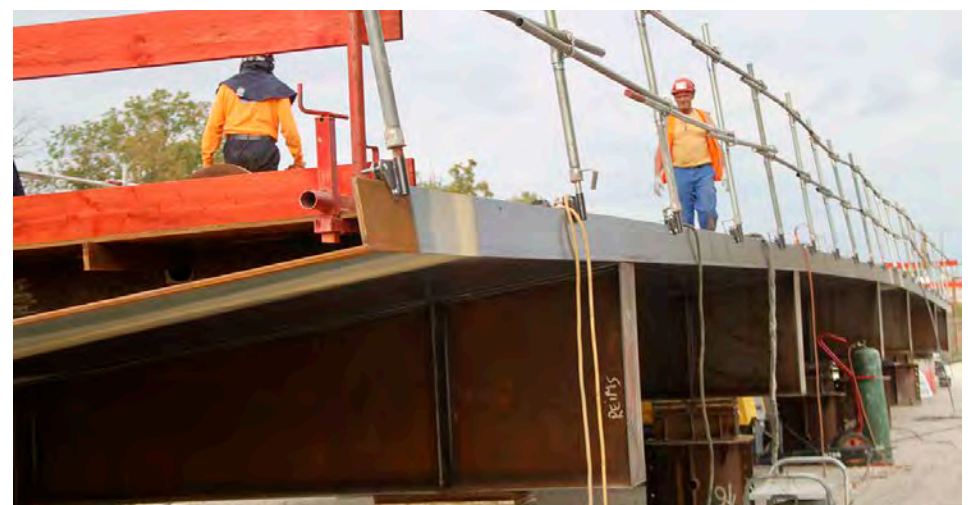
Le premier des cinq tronçons de la passerelle mesure 40 mètres de long. © l'Hebdo du Vendredi
