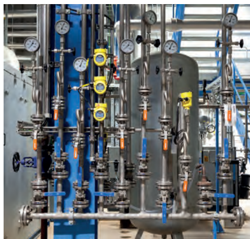
▲ Pomiar ciśnienia jest jednym z najczęstszych zastosowań w technologii pomiarowej dla przemysłu. Na zdjęciu: pomiar ciśnienia na wytwornicy pary.
