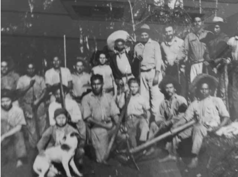
Trabalhadores na abertura de estradas
