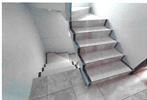
VISTA DE GRADAS DE ACCESO A TERRAZA
