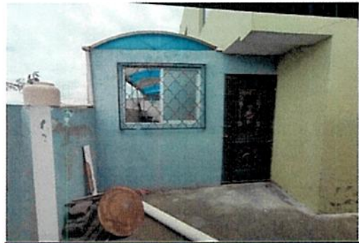
VISTA DE ÁREA DE SERVICIOS S1
