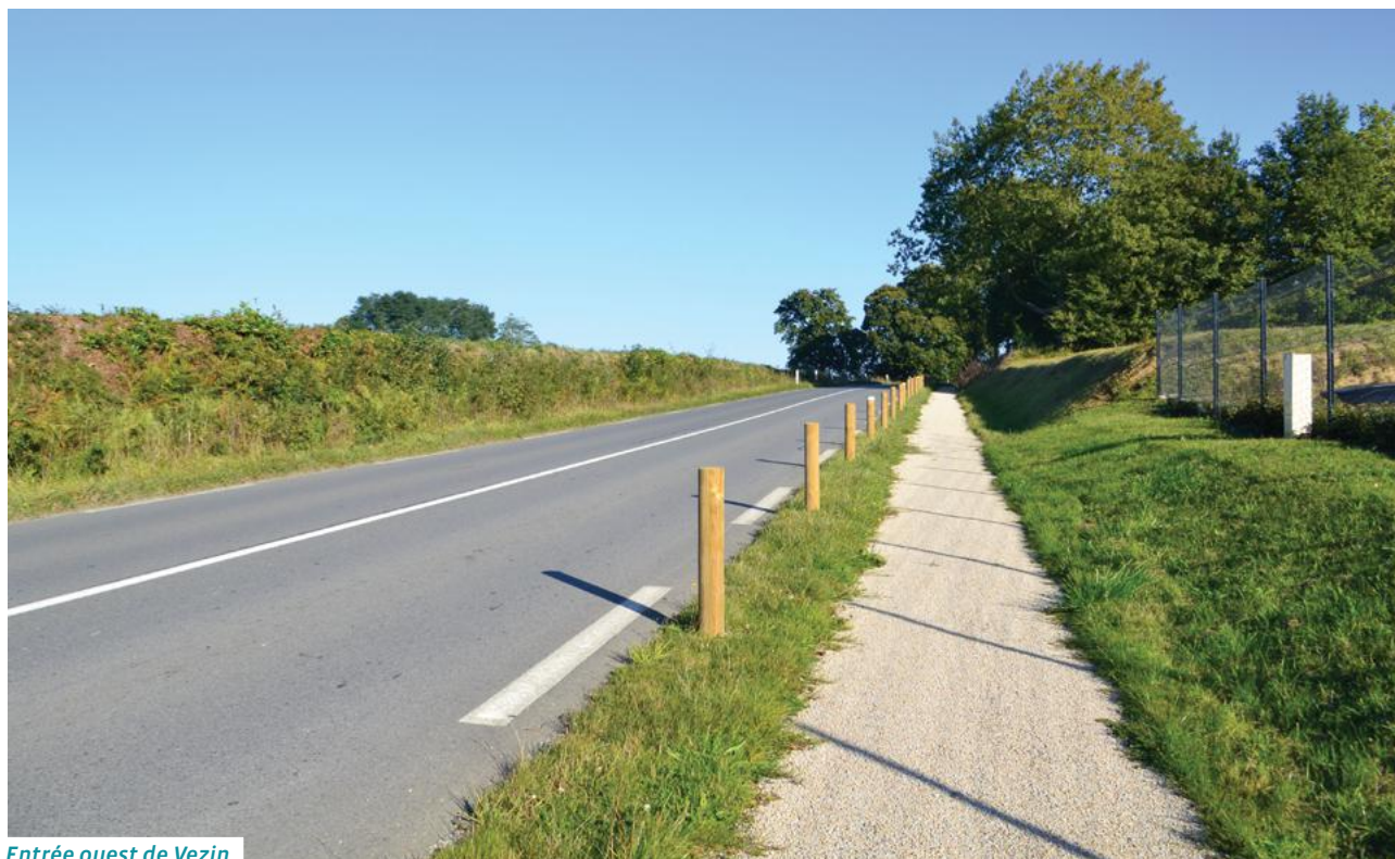
Entrée ouest de Vezin.
