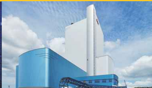
POWER PLANTS / KRAFTWERKE
