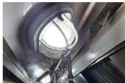
▲清除照明設備之防爆燈外層漆
