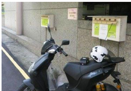
▲電動機車充電站
