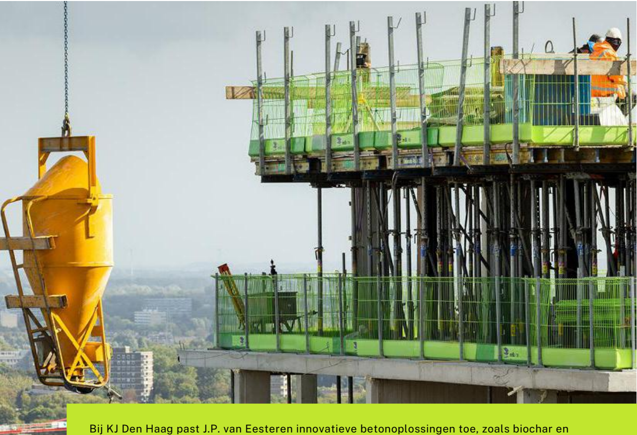
Bij KJ Den Haag past J.P. van Eesteren innovatieve betonoplossingen toe, zoals biochar en basaltvezelwapening, waarmee de CO 2 -impact van de bouw aanzienlijk wordt verlaagd.
