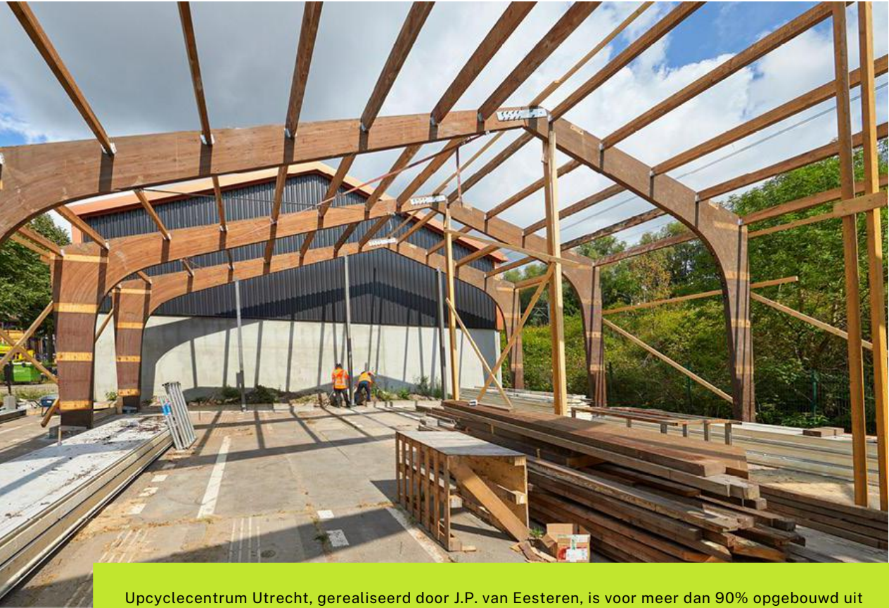
Upcyclecentrum Utrecht, gerealiseerd door J.P. van Eesteren, is voor meer dan 90% opgebouwd uit hergebruikte materialen, een krachtig voorbeeld van circulair bouwen in de praktijk.
