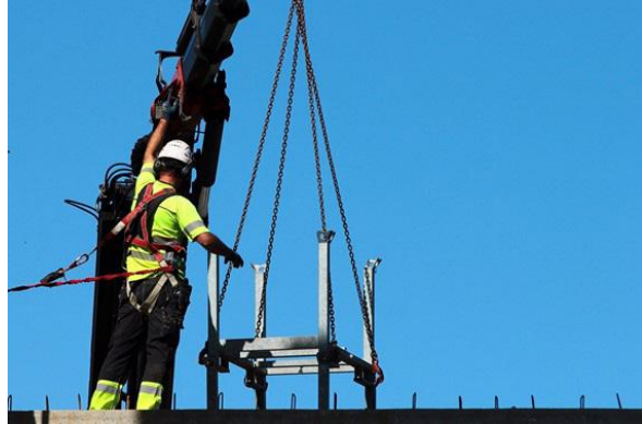
▲ شکل ۷: استفاده قلاب بند از تجهیزات حفاظت فردی مانند کمربند نجات
