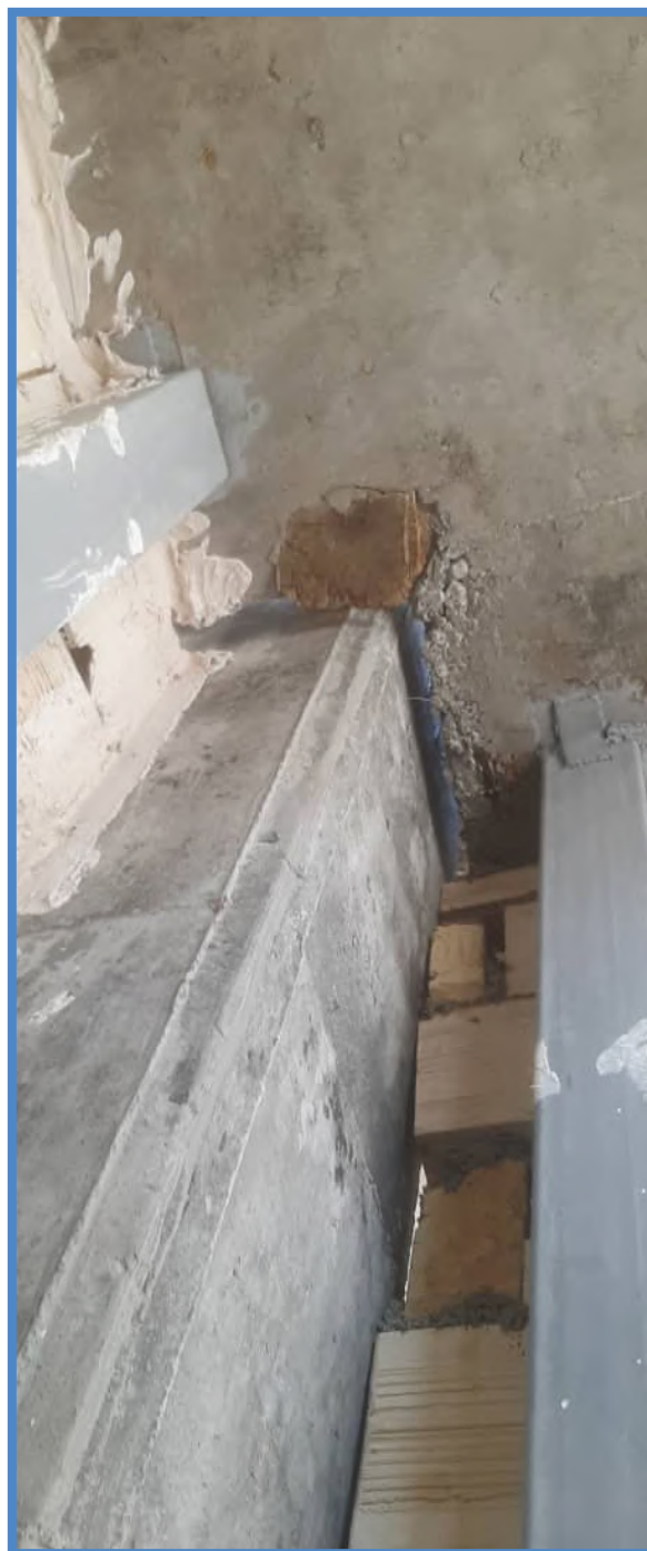
اجرای غیراصولی دال و شمشیری پله (عدم اتصال به ستون بتنی)
