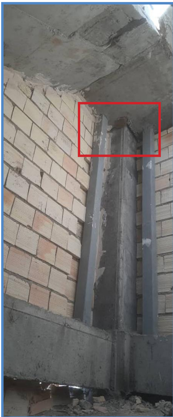
اجرای غیراصولی دال و شمشیری پله (عدم اتصال به ستون بتنی)
