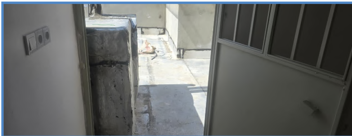
جانمایی نادرست کانال کولر و تداخل با در سرسرا
