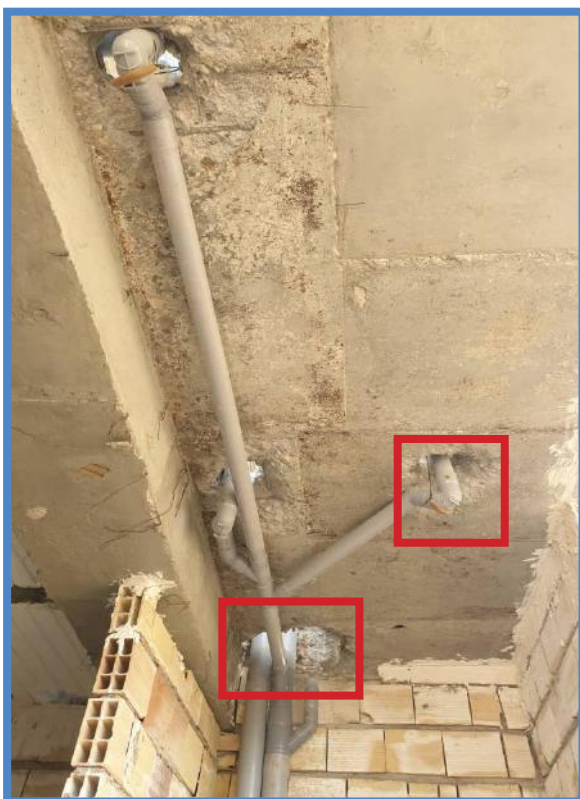
تخریب دال بتنی جهت عبور رایزرهای تأسیسات
