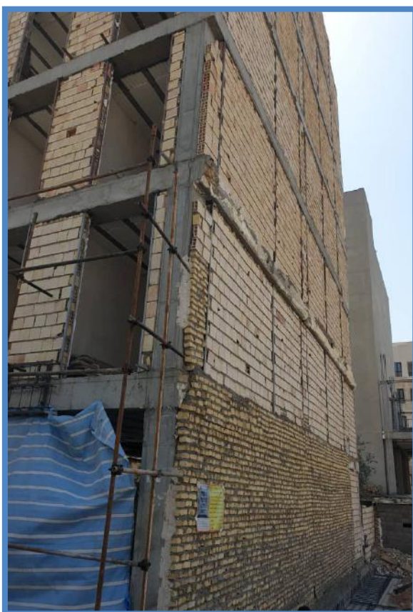
اجرای دیوارهای پیرامونی خارج از قاب سازه ای
