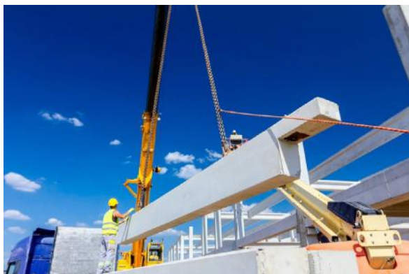
▲ شکل ۵: استفاده از طناب مهار برای جلوگیری از نوسان بار
