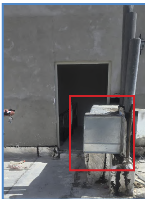
جانمایی نادرست کانال کولر و تداخل با در سرسرا
