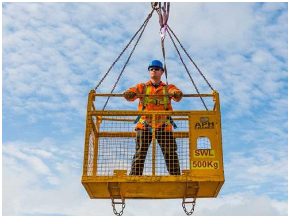
▲ شکل ۱۱: استفاده از هارنس در manbasket و اتصال آن با لنیارد به قلاب جرثقیل
