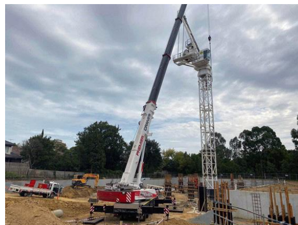
▲ شکل ۱۴: نصب جرثقیل برجی
